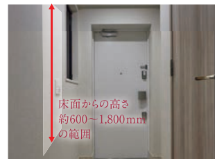
玄関手摺下地
